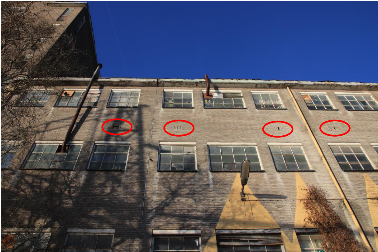
Foto 4: Spouwopeningen in de muur aan de oostzijde vormen een geschikte vaste rust- en verblijfplaats voor vleermuizen
