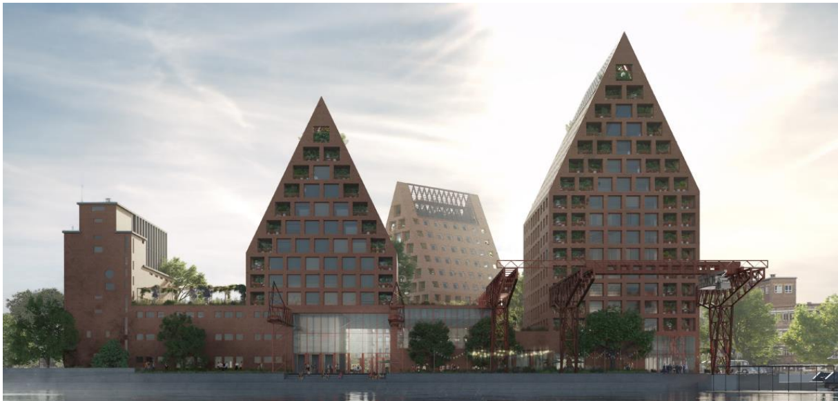
Figuur 4: In kleur: het meest linker gebouw en een deel van de basis van het gebouw aan de linkerkant betreft het te renoveren deel. De hoge driehoekige delen betreffen de nieuwe opbouwen met daarin geïntegreerd de voormalige industriële kranen. In de architectuur noemen ze dit een “gemengde plint”: basis is gelijk en op deze basis (de plint) verschijnen verschillende bouwstijlen met een gelijkend karakter.
