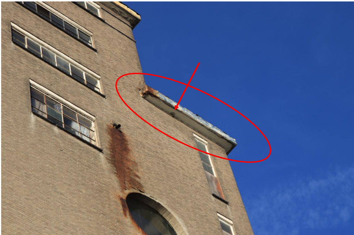
Foto 5: Nestlocatie van de huiszwaluw (pijl) onder de geschikte dakoversteek (rode ovaal)
